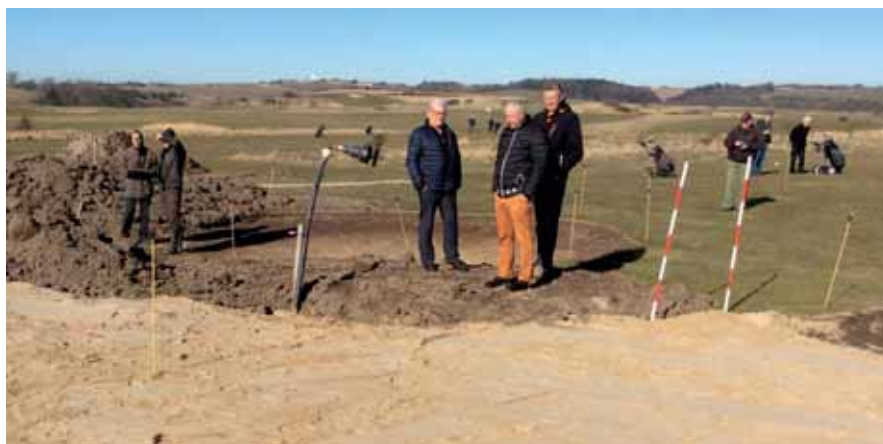
Henrik Jacobsen og Erling Raundahl på arbejde i en kommende greenbunker medens baneudvalget ser eftertænksomme ud.
