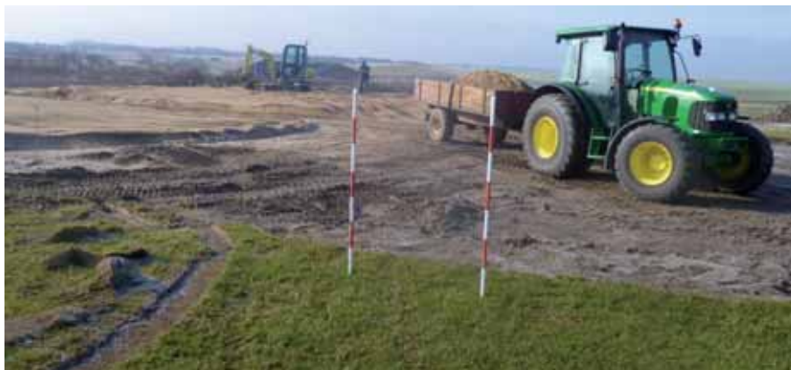
Anlægsarbejdet i fuld gang på hul 9
